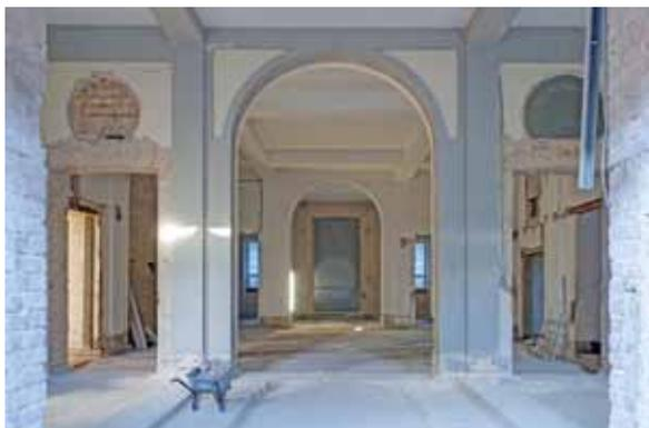
Im Erdgeschoss brauchen die Handwerker den alten Bodenaufbau bis auf die Gewölbedecken ab
